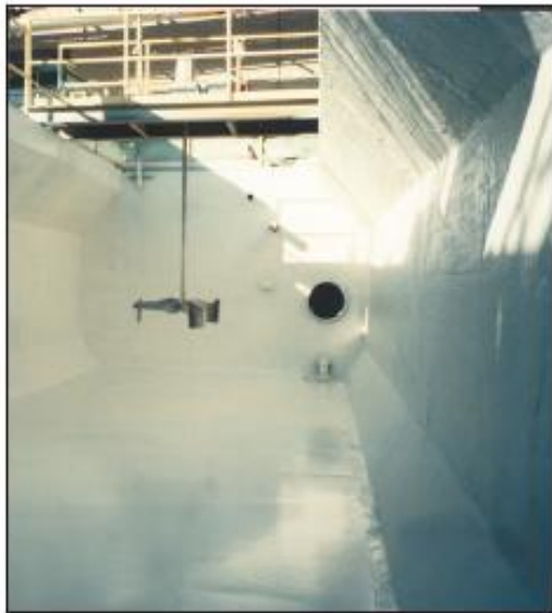
ChemLine®Primer 塗工後のコンクリート面
