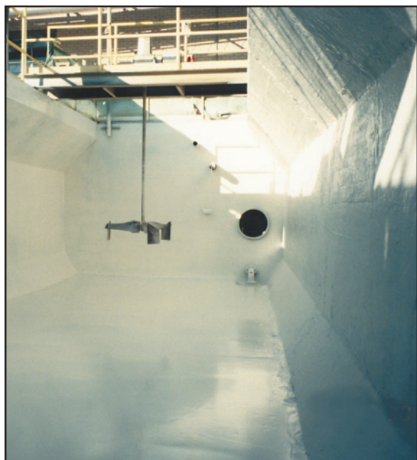
用于混凝土表面的完工的ChemLINE®底涂。
